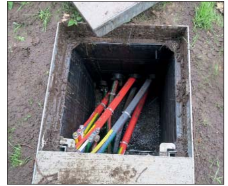
Bild 4: Zur Verlegung der Kabel können die Schächte bereits ab Werk mit Einführungsöffnungen in der erforderlichen Nennweite und Lage geliefert werden. Möglich sind Rohranbindungen in den Abmessungen DN 40 bis DN 160 (Fotos: Romold)
